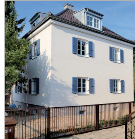
Kompakt, in schlichter Eleganz: Nach der rund sechs Monate dauernden sanften Sanierung hat das Kaffeemühlenhaus jetzt wieder ein klar gegliedertes »Gesicht« und erstrahlt im ursprünglichen Glanz
