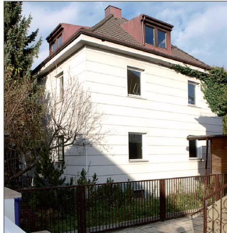
1930 erbaut – 1973 modernisiert: Optisch wie energetisch nach heutigen Erkenntnissen betrachtet, wäre dieses Münchner Kaffeemühlenhaus von den meisten Eigentümern wohl abgerissen worden
